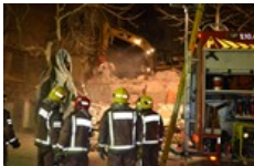
Esfondrament de l'edifici del Bar Perdiu
