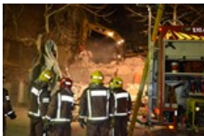
Esfondrament de l'edifici del Bar Perdiu
