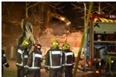
Esfondrament de l'edifici del Bar Perdiu
