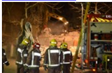
Esfondrament de l'edifici del Bar Perdiu
